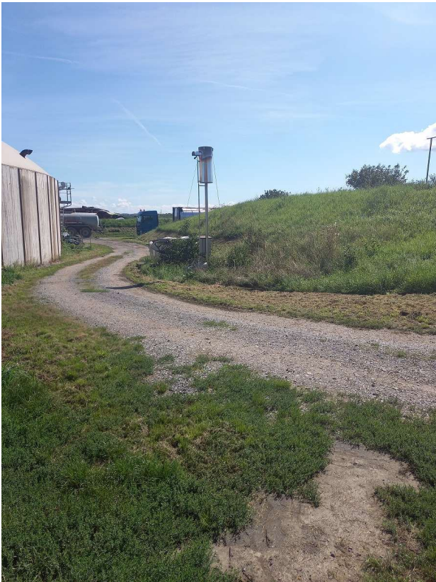
Abbildung 7 : Zufahrt vom lw. Feldweg in die Anlage
